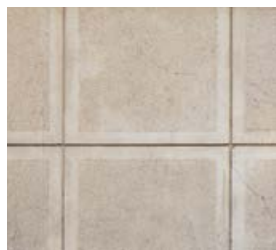
Tynk imitujący okładzinę kamienną, ul. Kielecka 40
