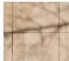
Tynk gładki imitujący okładzinę kamienną, ul. Madalińskiego 71
