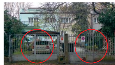
Niespójne, indywidualne rozwiązania remontowe, ul. Madalińskiego/ul. Karłowicza
