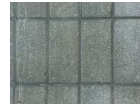
Płytki z zielonoszarego lastryko w cokole, ul. Kazimierzowska 51
