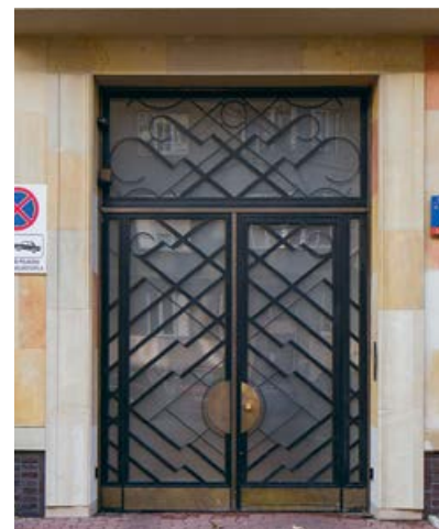
Brama po remoncie, ul. Narbutta 22
